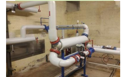
Echangeur tubulaire
