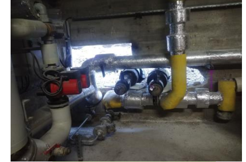
Ouvertures dans la sous-station pour le raccordement
