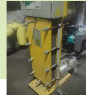
Echangeur à plaques
