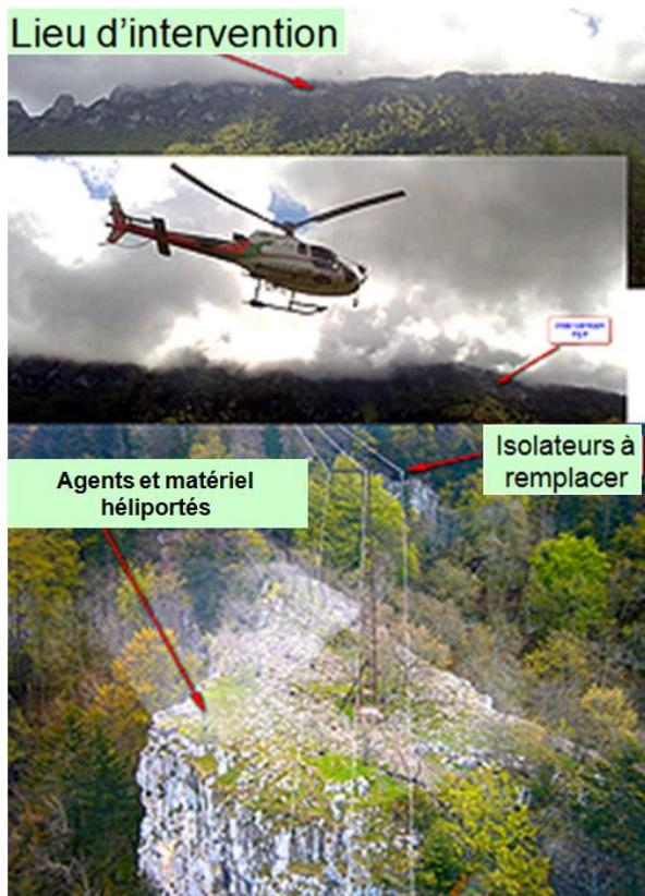
Suite à une panne sur un départ et après des premières recherches infructueuses en zone accessible, une visite de ligne par hélicoptère a été décidée, sur le dernier tronçon qui pouvait être à l'origine du défaut sur le réseau. Le repérage aérien a permis de vérifier le diagnostic des techniciens : la panne provenait d'isolateurs à remplacer.
