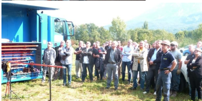
Travaux sous Tension (TST)
