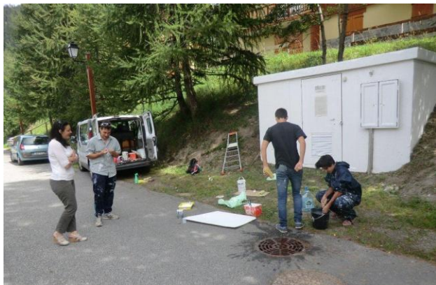
La préparation du chantier
