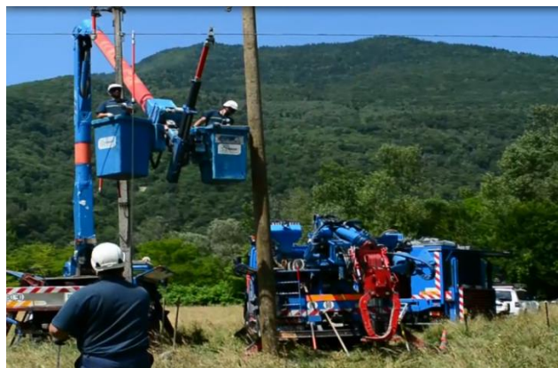
Intervention à haut risque en Plaine de RANDENS : changement d'un support d'une ligne HTA sous tension, en présence de Morgan TANGUY, Sous Préfet de Savoie et de nombreux élus
