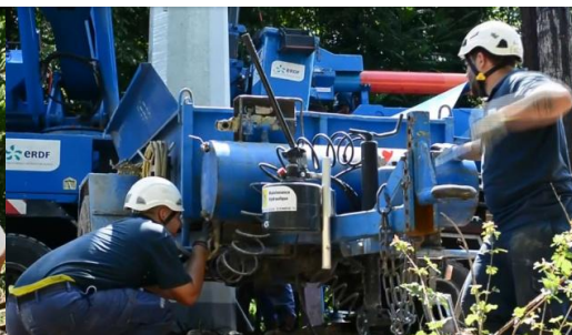
Travaux de pose d'un poteau
