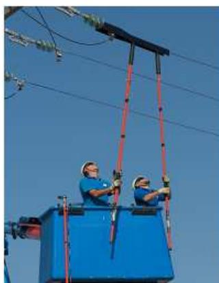
La pose d'isolant sur le fil
