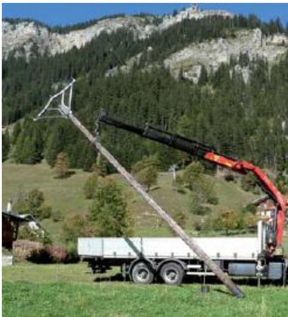
**PRALOGNAN LA VANOISE** : le 5 octobre 2011, dépose du dernier support (pose de **5,5 km** de réseau HTA souterrain - Dépose de **4,5km** de réseau aérien). La sécurisation du réseau électrique s'est inscrite dans la promotion d'une image de développement durable souhaitée par la commune.
