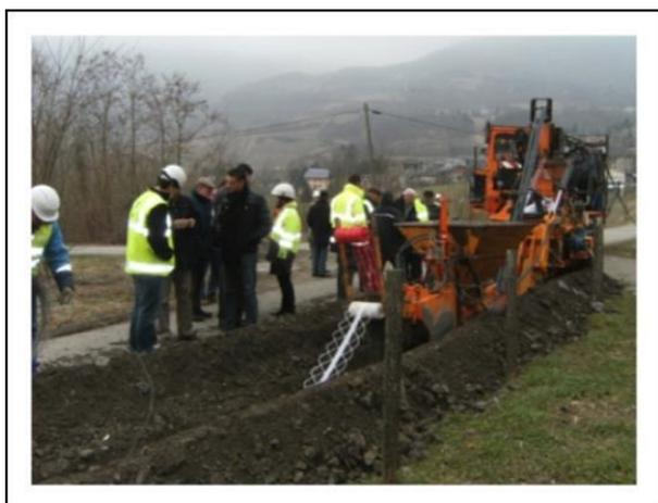
**SAINT PIERRE D'ALBIGNY** : février 2011, début du chantier de pose de **23km** de réseau **HTA souterrain** avec reprise de **7 postes** de distribution publique et dépose de **17 km** de réseau **HTA aérien**. 230 supports seront enlevés sur le départ les Aillons. Le tracé se situe en zone sensible d'un point de vue faunistique, floristique et hydrogéologique.
