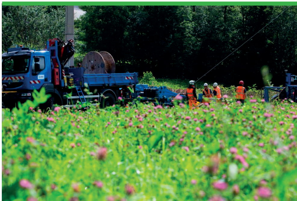
Tirage de Câbles
