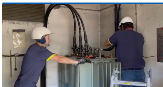
Chantier école dans un poste de transformation
