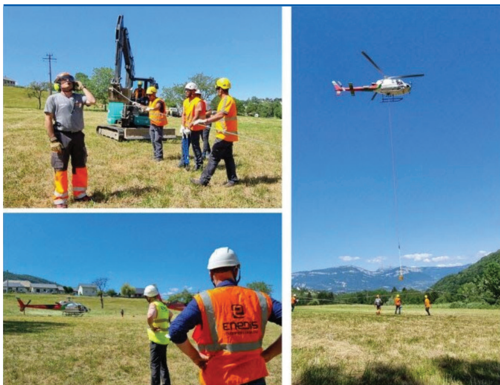
Chantier d'hélicoptage d'une ligne HTA sur VIMINES
