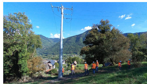
Visite chantier RP
