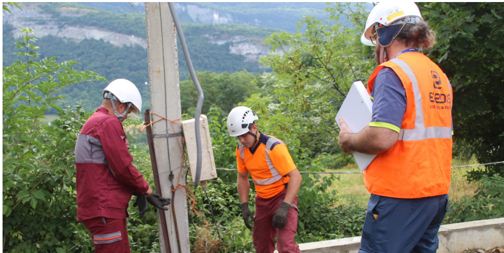
Visite de sécurité d'un chantier réalisé par l'entreprise CITEOS
