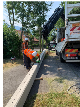
Travaux de remplacement de support
