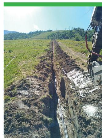
Ce chantier présentait des particularités bien spécifiques. Le tracé d'enfouissement a été pensé en fonction de la zone d'implantation d'une espèce de plante protégée, la swertie vivace. Les conditions d'acheminement (plus d'un kilomètre de piste en forte pente) ne permettaient pas la rotation des camions : la terre excavée a été conservée et redispesée à son emplacement initial. Enfin le démontage des 50 poteaux de la ligne démontée a nécessité l'utilisation d'un hélicoptère.
